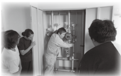
水害想定訓練
